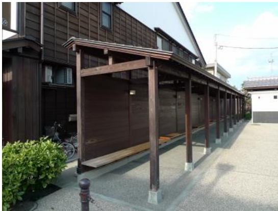
通路や休憩スペースへのこみせの設置
