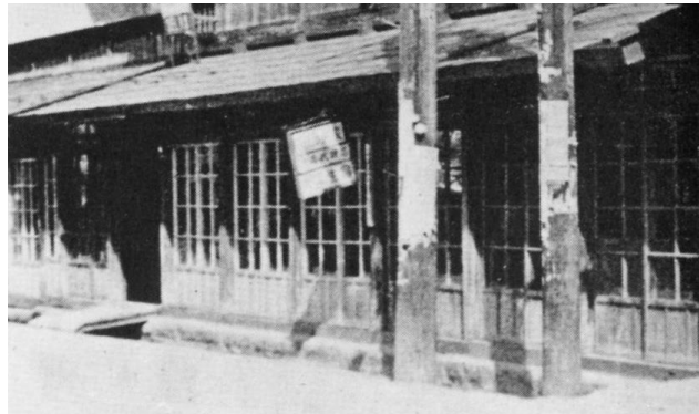
昭和8年 中村亀吉酒造店前の側溝部
