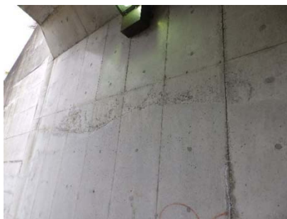
大型カルバート老朽化状況例（左：打継ぎ目 中央：ひび割れ＋漏水 右：鉄筋露出）
