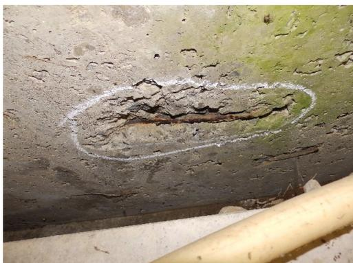
写真 3-1 中性化による損傷状況
