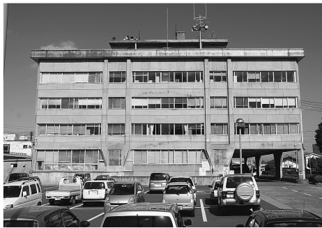
黒石市役所本庁舎
