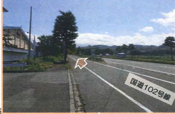
黒石インターチェンジ入口
