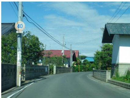
庭木と蔵が連続し、落ち着いた佇まいの感じられるまち並み（高館）
