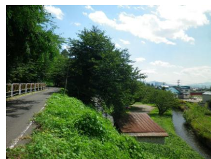
崖地に造られた宇和堰（上方）と小阿弥堰（下方）陣屋が自然の土地を利用した要塞であったことを物語る
