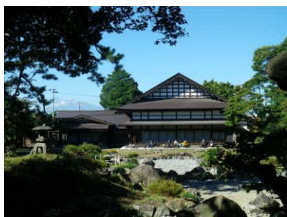
保存修理事業の進む金平成園 西方には岩木山を望むことができる
