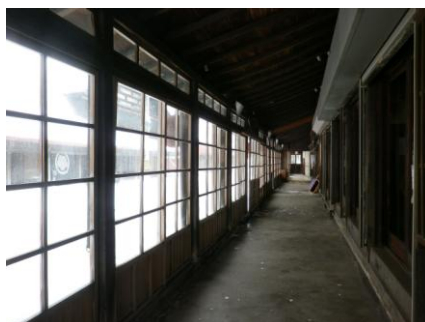
ガラス戸が設けられたこみせ（中町）
