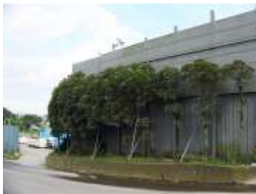
外周に植栽帯を設け、中木を配置している例
