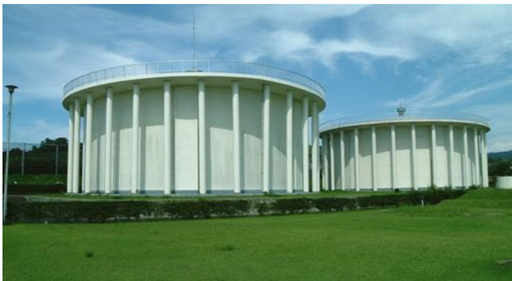
牡丹平配水場
