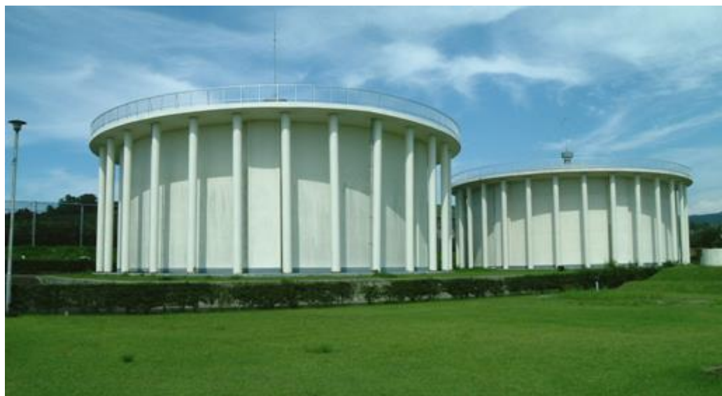
牡丹平配水場
