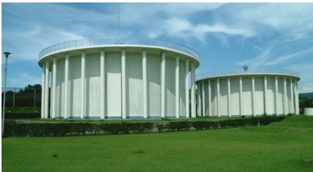
牡丹平配水場
