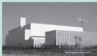
■環境整備センター
