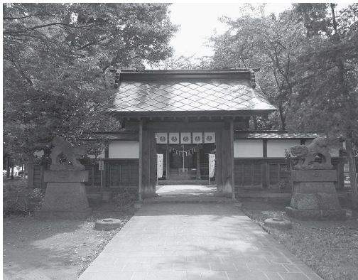
黒石陣屋の建造物で唯一現存する神門
