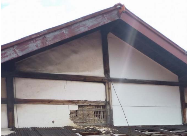
西側破風面には土壁の破損が見られる。隣接する一間（写真右側）は既に壁が崩れ、ボードで塞がれていた。ボードで隠れていた貫は復原する。
