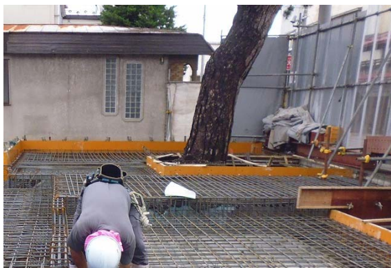
松の木廻りの配筋の様子
