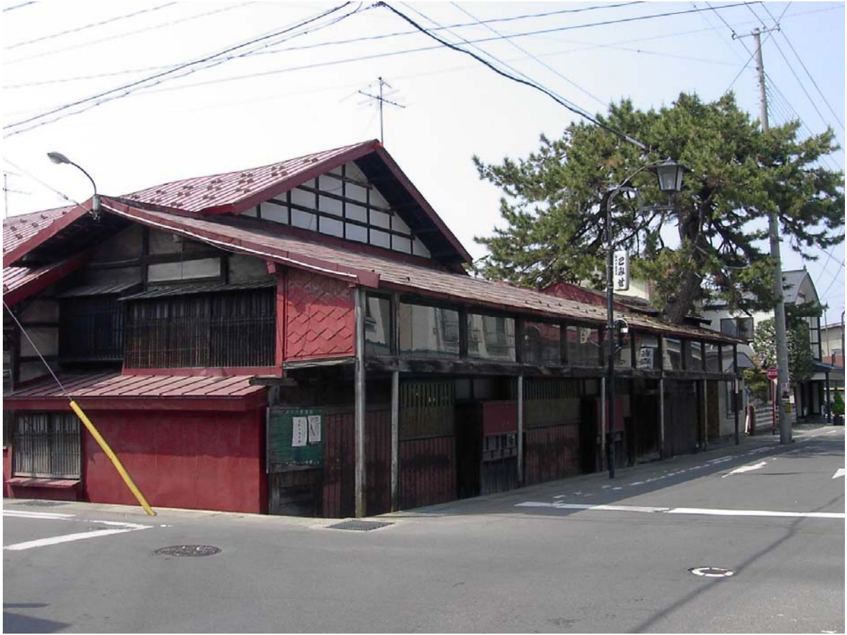
南東角より（解体保管前）
