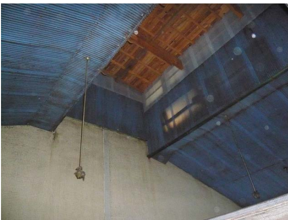
浴室天井（湯気抜き）（既存）
