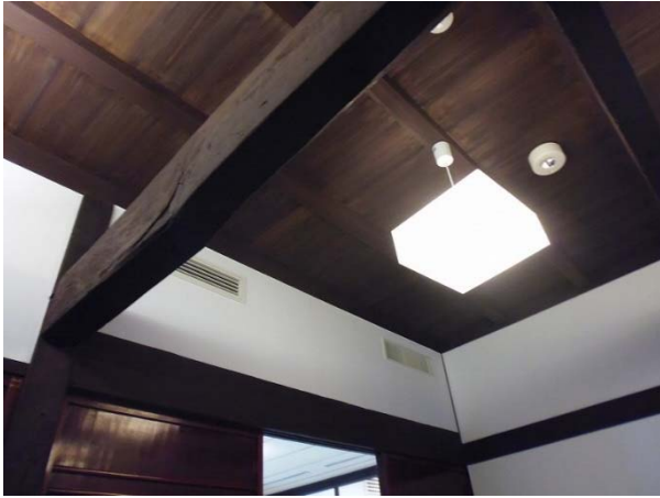
休憩所1の根太天井（竣工）
