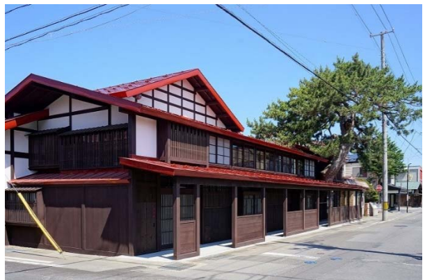
復原後の旧松の湯：こみせ通りから（竣工）
