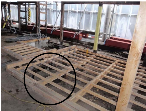
旧台所の床を撤去した状態（解体）
