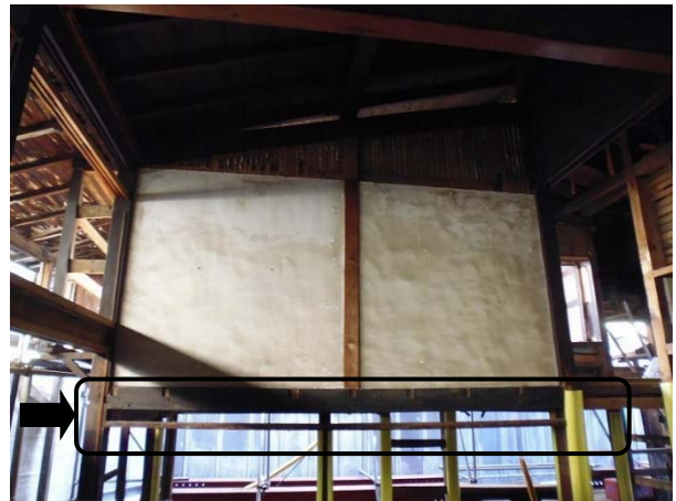
女子脱衣室 Y4 通りの仕上げを撤去した状態（解体）
