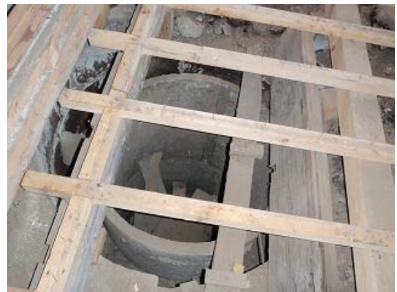
旧台所の床下に確認された井戸
