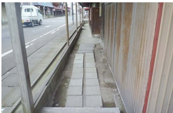
こみせを北側より見る。道路との段差が見て取れる（既存）
