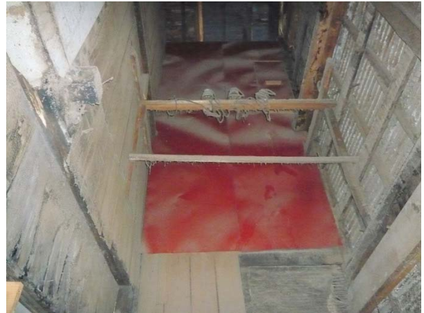
釜場の上部は吹抜けとなっていた（既存）
