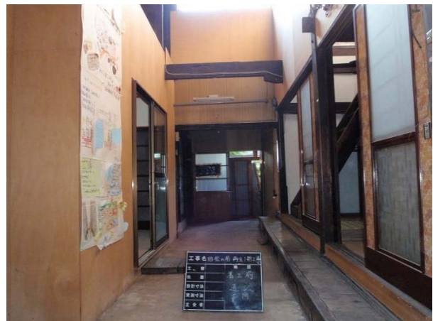
通り土間・西側を見る（既存）
