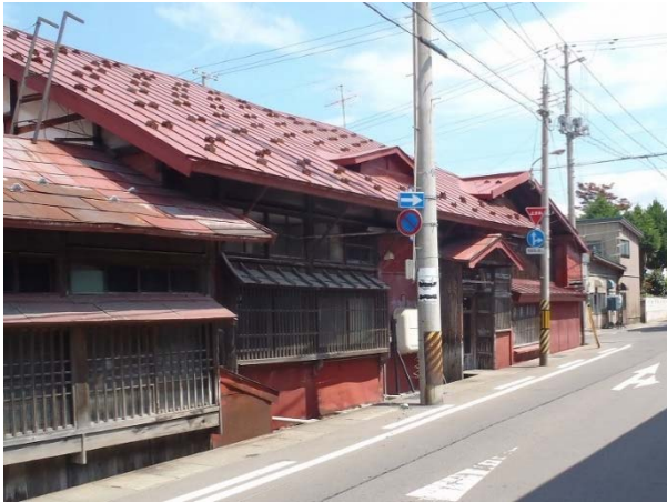
外壁木板縦張り部のほとんどは鉄板で被覆されていた（写真は南面）。赤い外観が印象的であるが、本来の姿とは異なり、町並みにおいても異色の存在。
