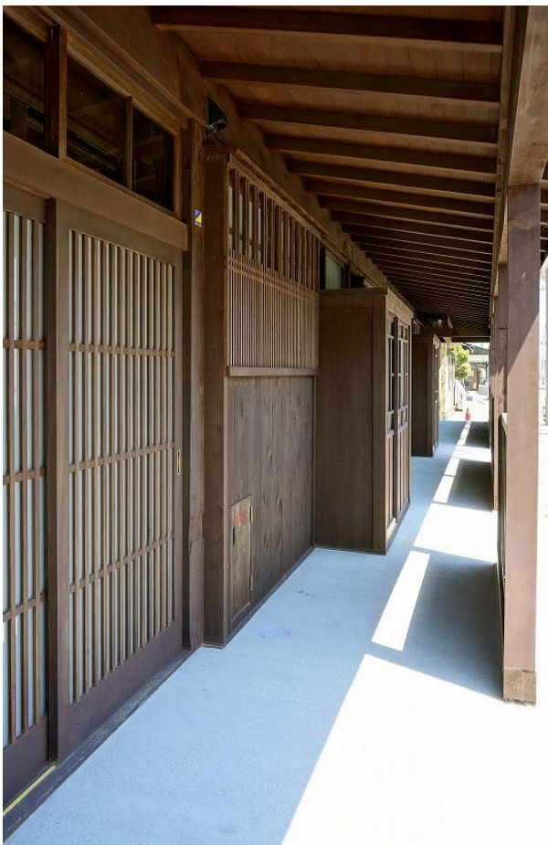
こみせを南側からみる。こみせの歩行面は道路面と面を合せたものとして調整され、段差を解消している。
