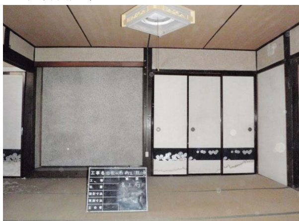
座敷(東)東面(既存)
