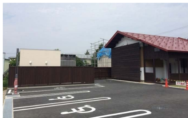
土蔵西側隣地境界塀等(竣工)
