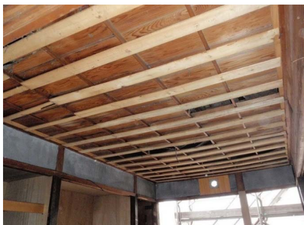
座敷(西)の天井を剥がしたところ(解体)
