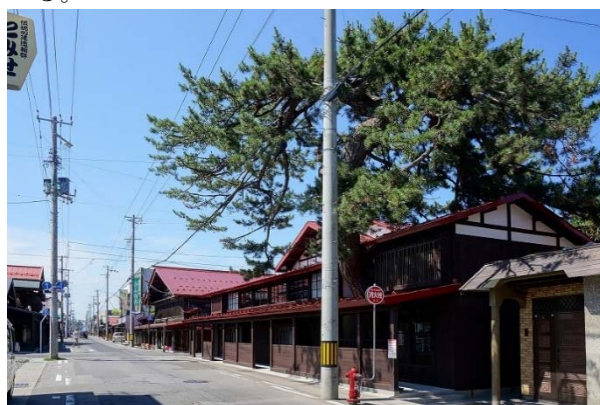
こみせ通り北側から見る。復原されたこみせが、西谷家をはじめとした南側の町並みに連なる様子が分かる
