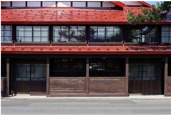
1間毎に設けられた柱と蔀（竣工）
