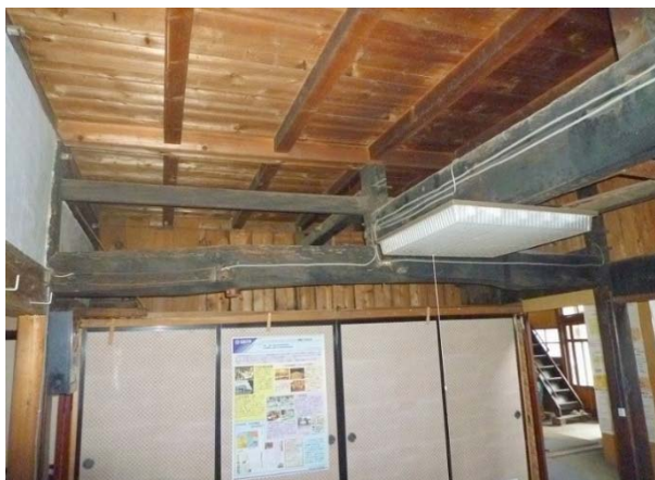
旧茶の間の根太天井 材の時期が新しい（既存）
