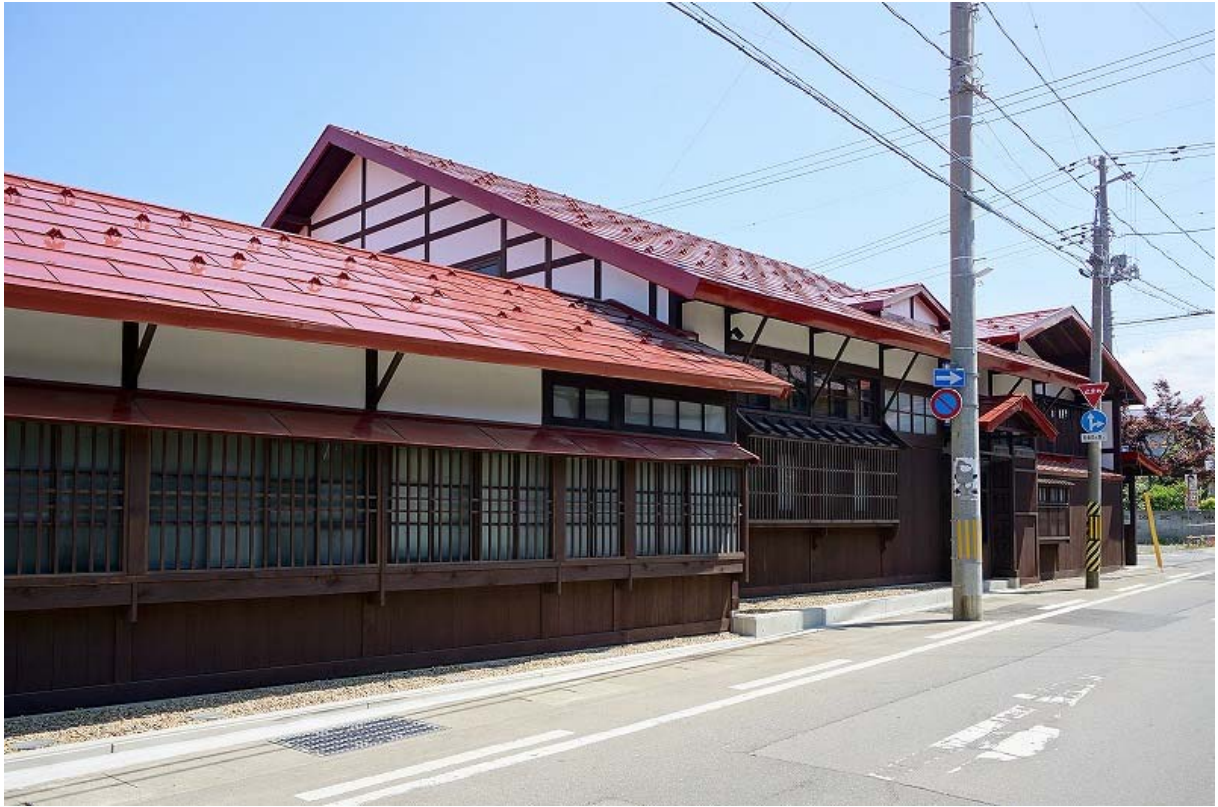
南面（復原再生後）
