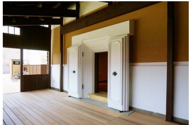
土蔵南面（竣工）
