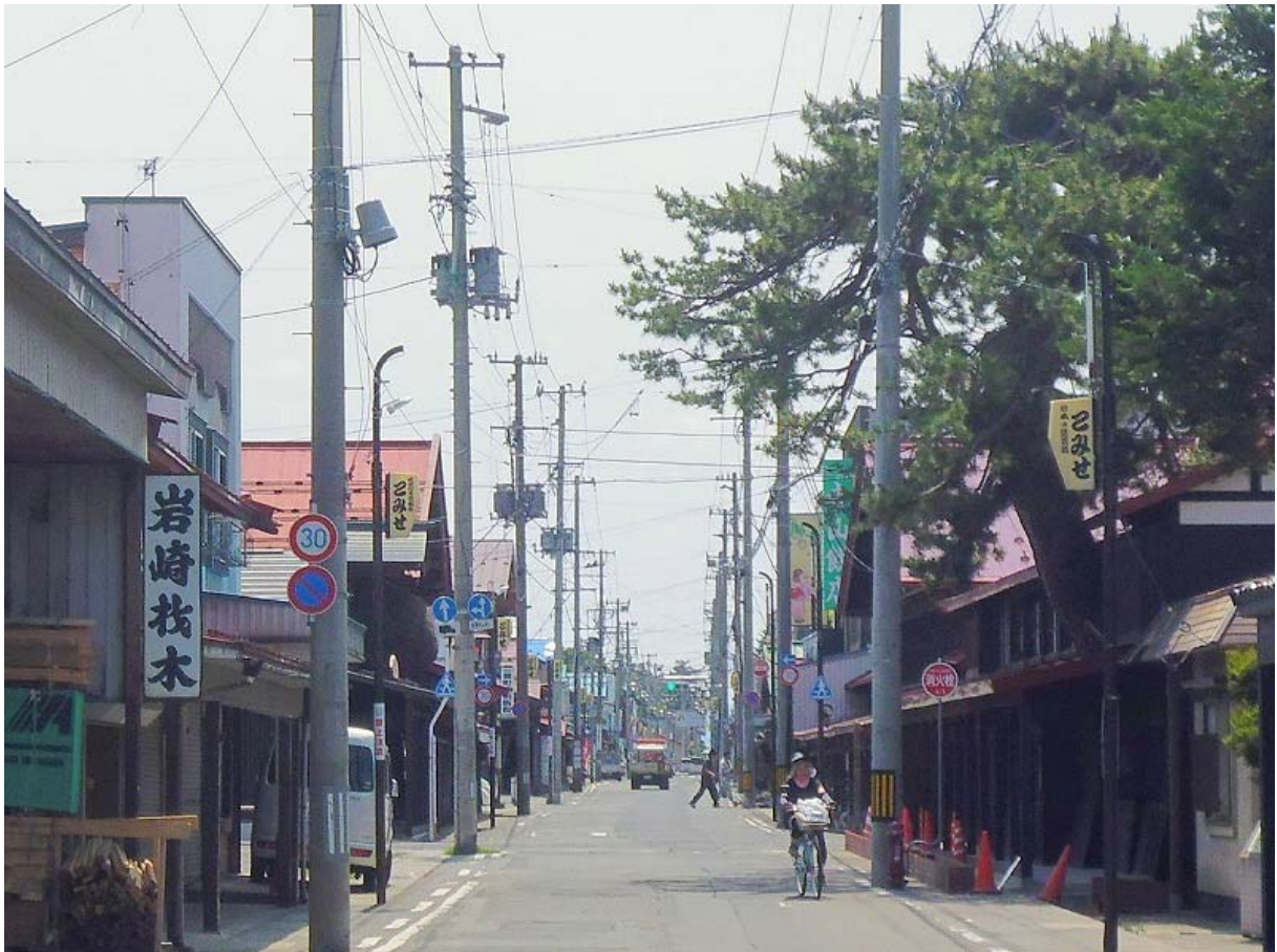
こみせ通り北側から（復原再生後 平成27年）
