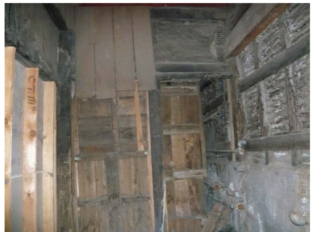
釜場内部。左手が茶の間、右手が浴室（既存）
