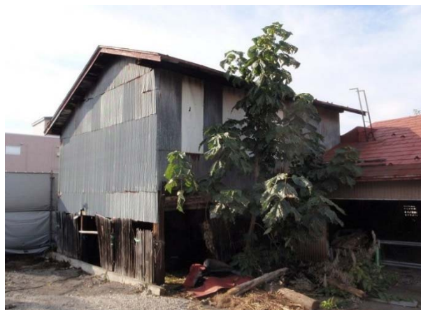
昭和期に増築された燃料庫。右奥が土蔵西の燃料庫(既存)
