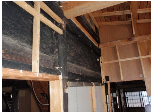
旧和室（西）の仕上げを撤去した状態（解体）
