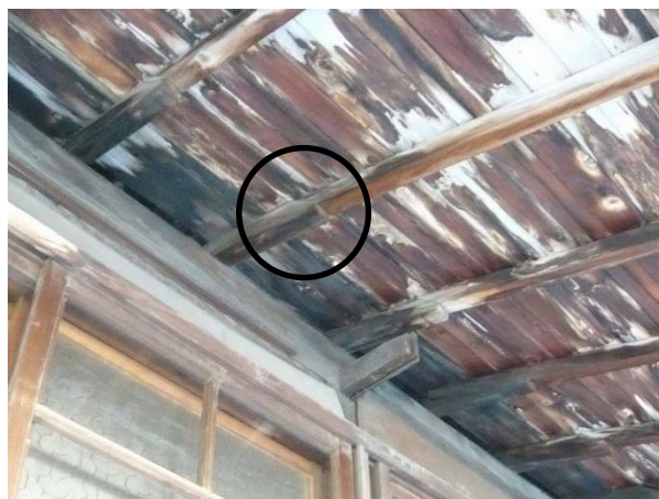
主屋から道路側に垂木を延長した痕跡（既存）
