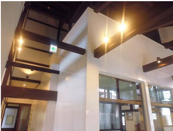
通りの間からみた観光展示室（竣工） しっくい真壁の中に独立した箱としてみせる
