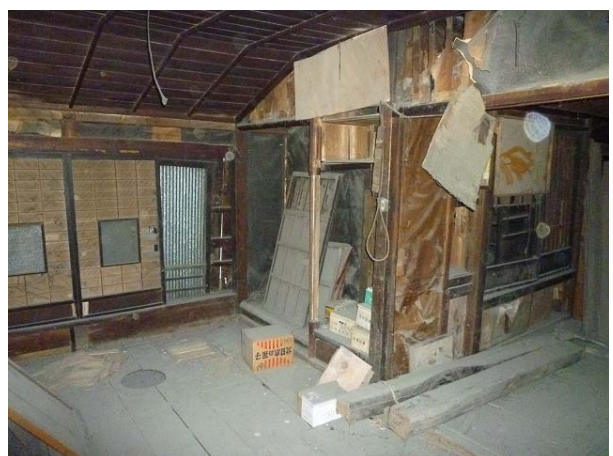
旧床屋2階和室（既存）
