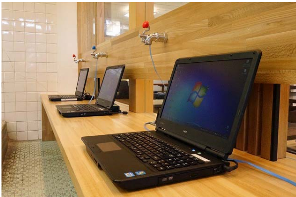
解体した男子浴室の蛇口を転用した LAN 配線（竣工）
