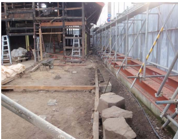
物置側より土台をみる（解体）
