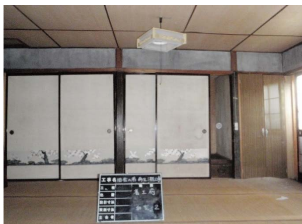
座敷(西)西面(既存)
