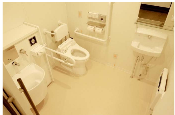
多目的トイレ内部（竣工）
