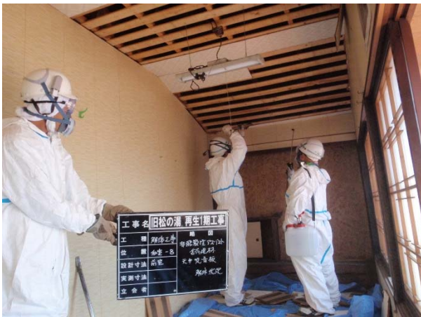
通り土間2階和室の天井撤去 内装は昭和期後半に改修が行われている（解体）
