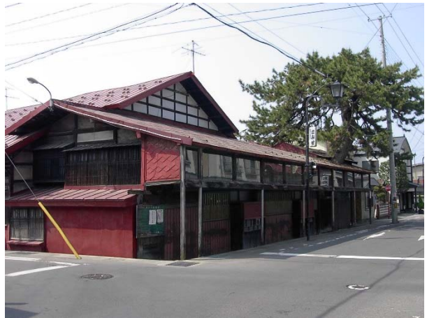
解体前の旧松の湯：こみせ通りから（既存）
