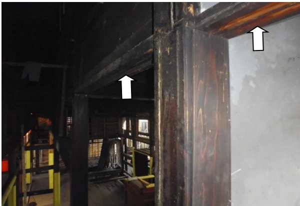
鴨居の痕跡 (X20 通)。写真左手は廊下状の空間 (解体)
