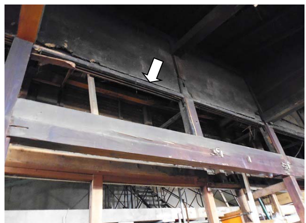
鴨居の痕跡（X20 通）（解体）
