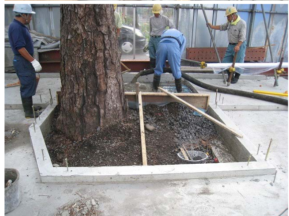
松の木廻りのコンクリート打設の様子
