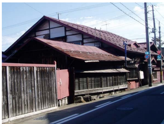
南西側から見る
