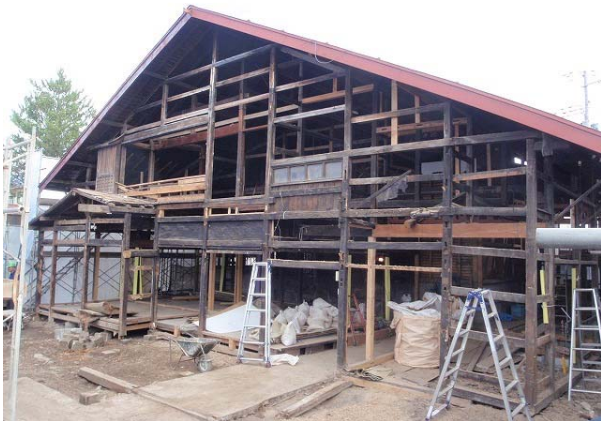
X8 通りの軸組を西側から見る（解体）
