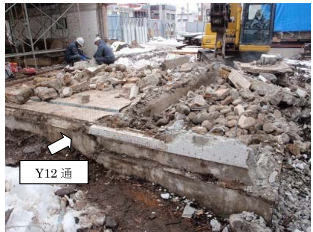
Y12通の床下に確認された基礎（解体）
