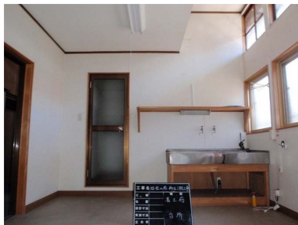
旧台所 (東面をみる/奥がユニットバス) (既存)
