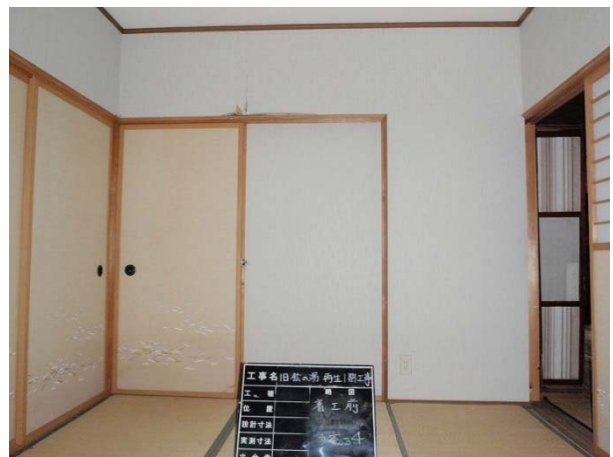
解体前の和室（西）。右手は茶の間（既存）
