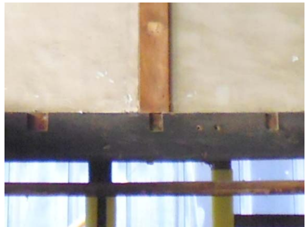
根太の痕跡（解体）
