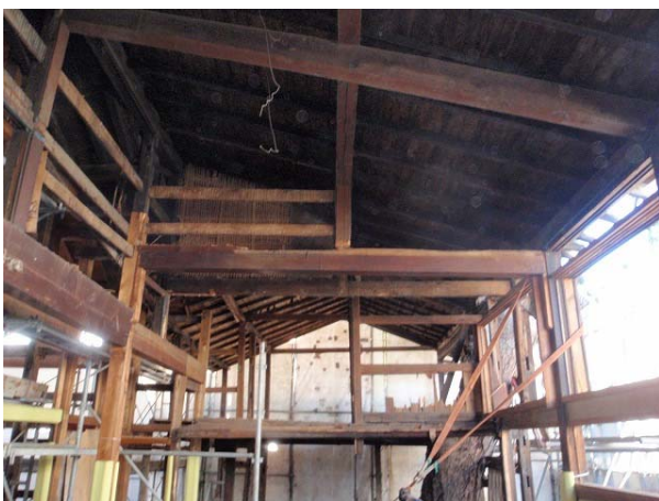
男子脱衣室側より旧床屋との取合い部（解体）
