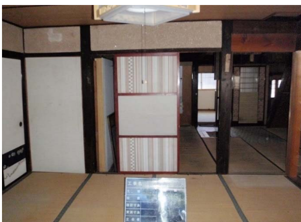
座敷(東)南面(既存)
