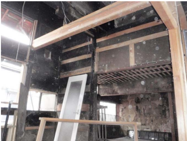
旧台所の仕上げを撤去した状態（解体）
